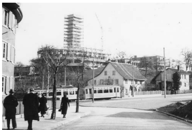
Die Kirche Auf der Egg während des Baus im Jahr 1936: Eine der ersten Kirchen Zürichs mit Betonkonstruktion
