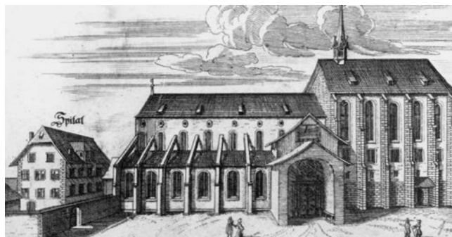
Die Predigerkirche: Ihre Fassade macht die Baustatik mit Strebepfeilern und den Umbau vom Kloster zur Kirche sichtbar
